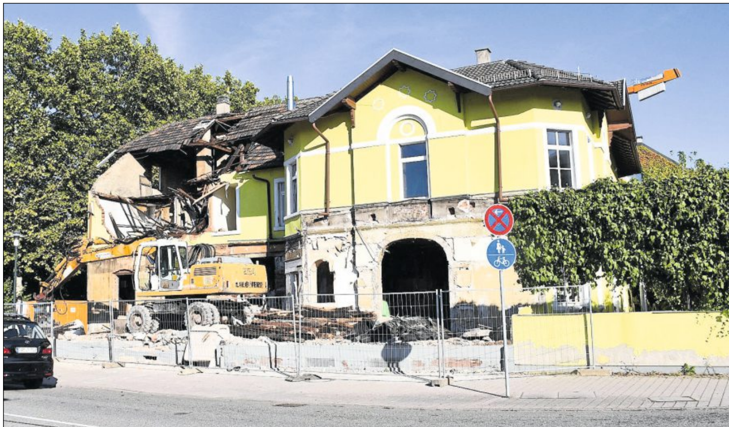
ABRISS: Der rückwärtige Trakt der denkmalgeschützten „Alten Post“ muss dem Bagger weichen. Dort entsteht für die Hilfsorganisation Pallium ein barrierefreier Neubau. Foto: Margull
